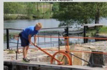
Slusene betjenes fortsatt med håndmakt
